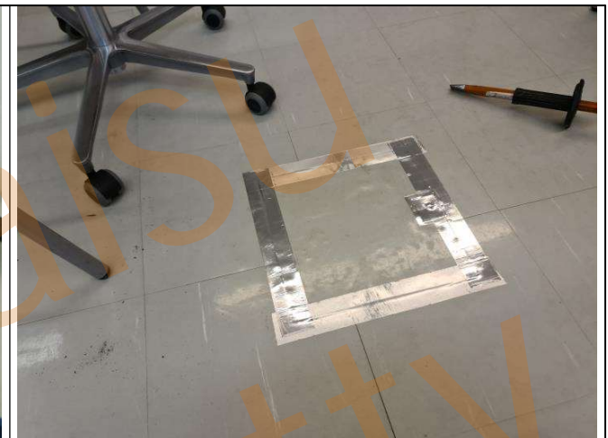
Kuva 6. Avattu luukku teipattiin ilmatiiviisti luukun tarkastuksen jälkeen.
