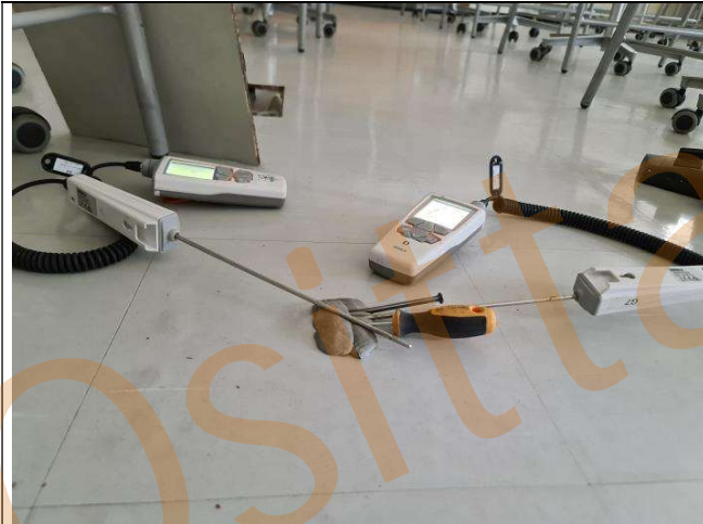
Kuva 7. Viiltokosteusmittaus V2. Viiltomittauskohdassa on lattiapäällysteessä myös pieniä kohoumia (vasemmalla).
