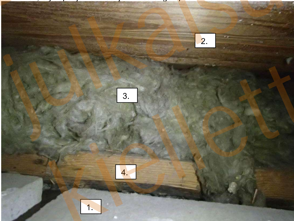
Kuva 14. Rakenneavaus RAKS 10. Valokuva eristetilasta KAHI-tiilen päältä ylkäpohjan eristetilään: 1. KAHI-tiili, 2. vesikaton vaneri, 3 ylkäpohjan eristeet ja 4. sisärungon päällä oleva vaakalankku.
