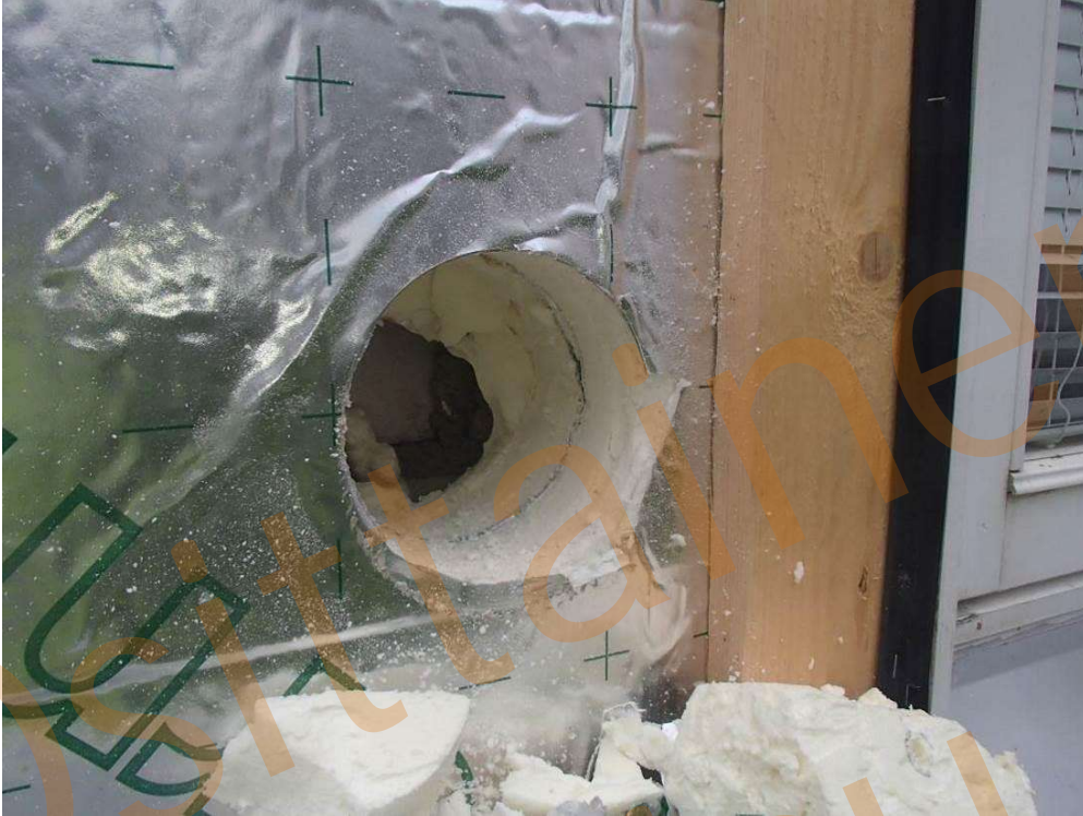
Kuva 92. Rakenneavaus, RAKS 25, länsisiiven ikkunoiden väliin.
