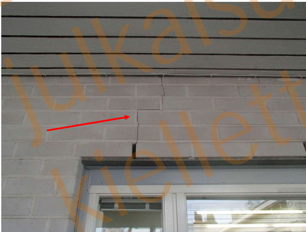
Kuva 137. Tiilimuurauksen halkeilua.
