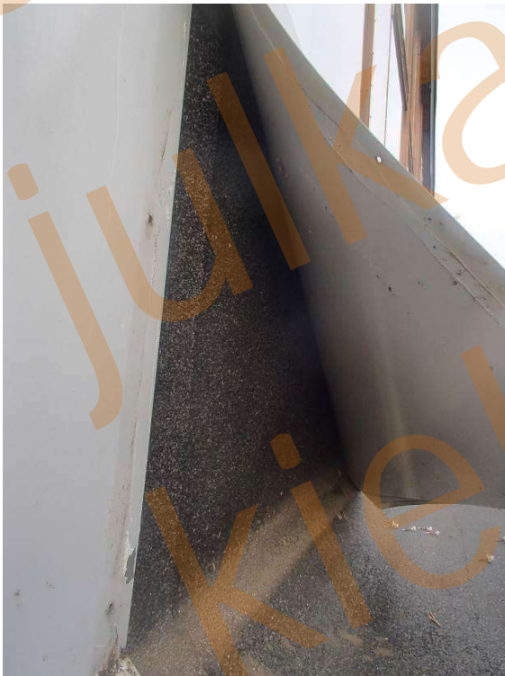
Kuva 152. Juhlasalin bitumikermin ylösnosto.
