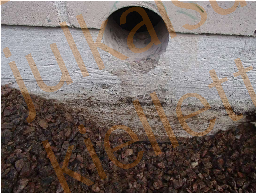
Kuva 71. Liikuntasalin sokkelin ulkopinnassa havaittiin bitumikermieristys noin 80 mm maanpinnan alapuolella.
