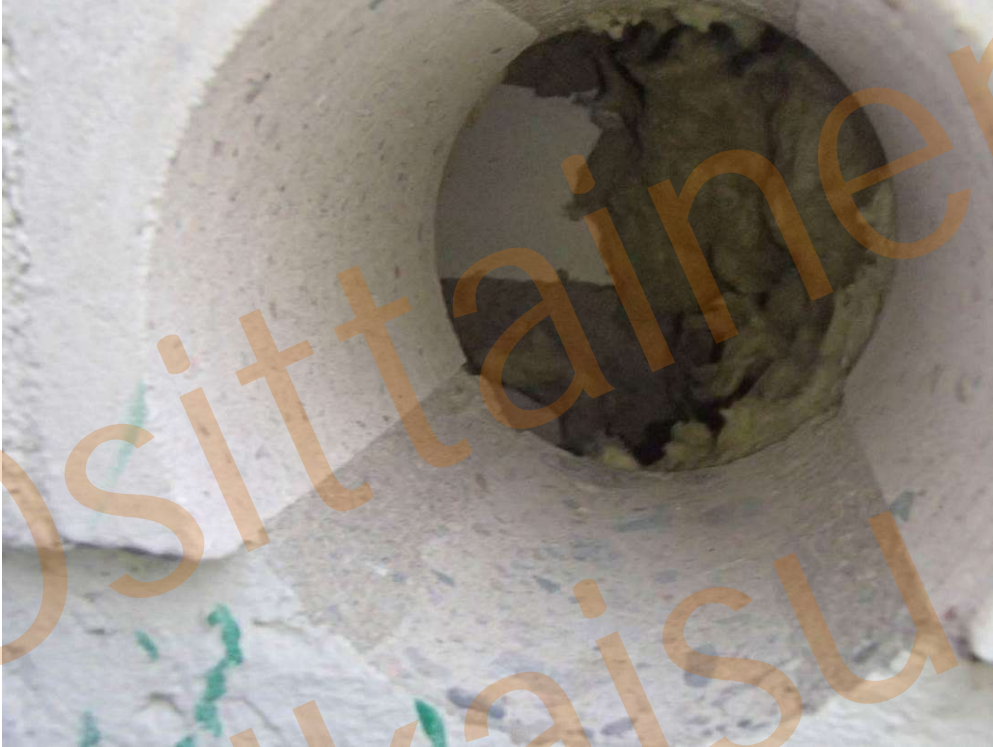
Kuva 72. Rakenneavaus, RAKS 15, liikuntasalin pohjoispuolen sisäkulmaan.
