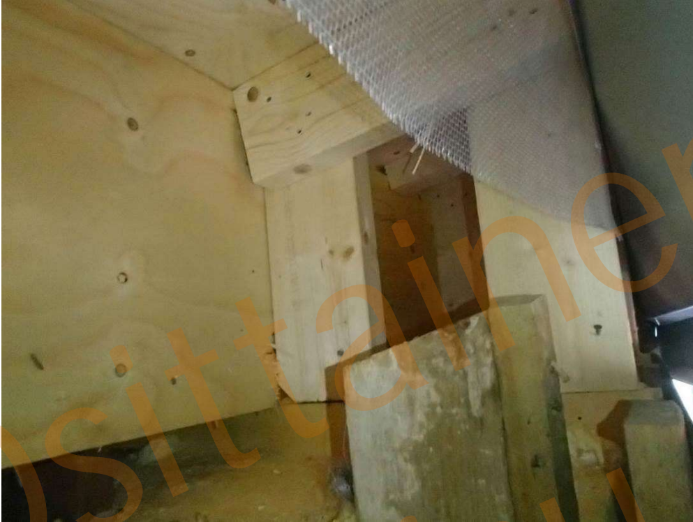
Kuva 99. Rakenneavaus, RAKS 29, liikuntasalin länsisivun räystäsrakenteeseen. Rakenteet uuden otsapellityksen takaa ovat uusittuja.
