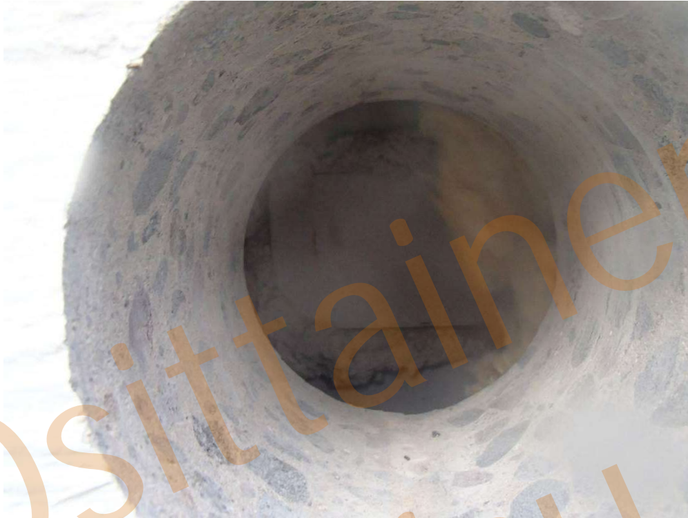
Kuva 5. Rakenneavaus, RAKS 2, itäsiiven sokkelirakenteeseen.
