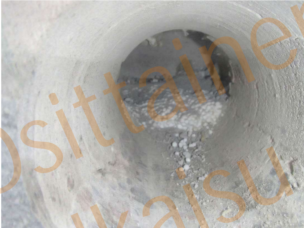
Kuva 7. Rakenneavauksen, RAKS 4, yhteydessä ei havaittu kapillaarikatkoa betonisokkelin ja tiilimuurauksen välissä.
