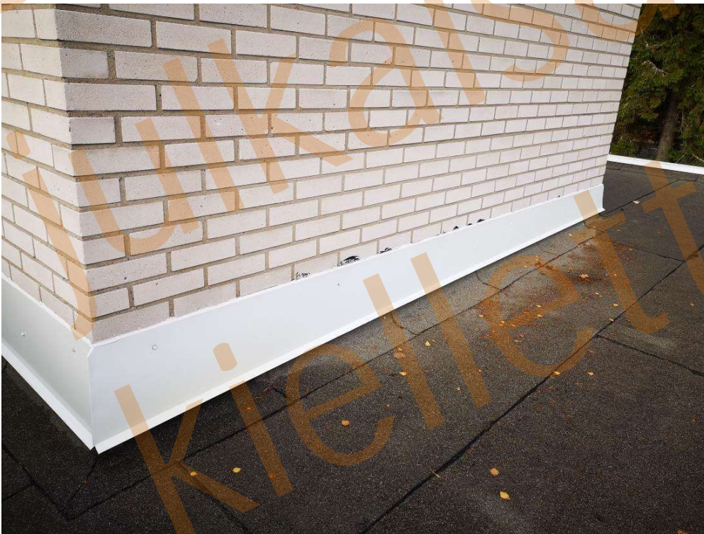
Kuva 154. Keittiön yläpuolen rakennelman pellitykset.
