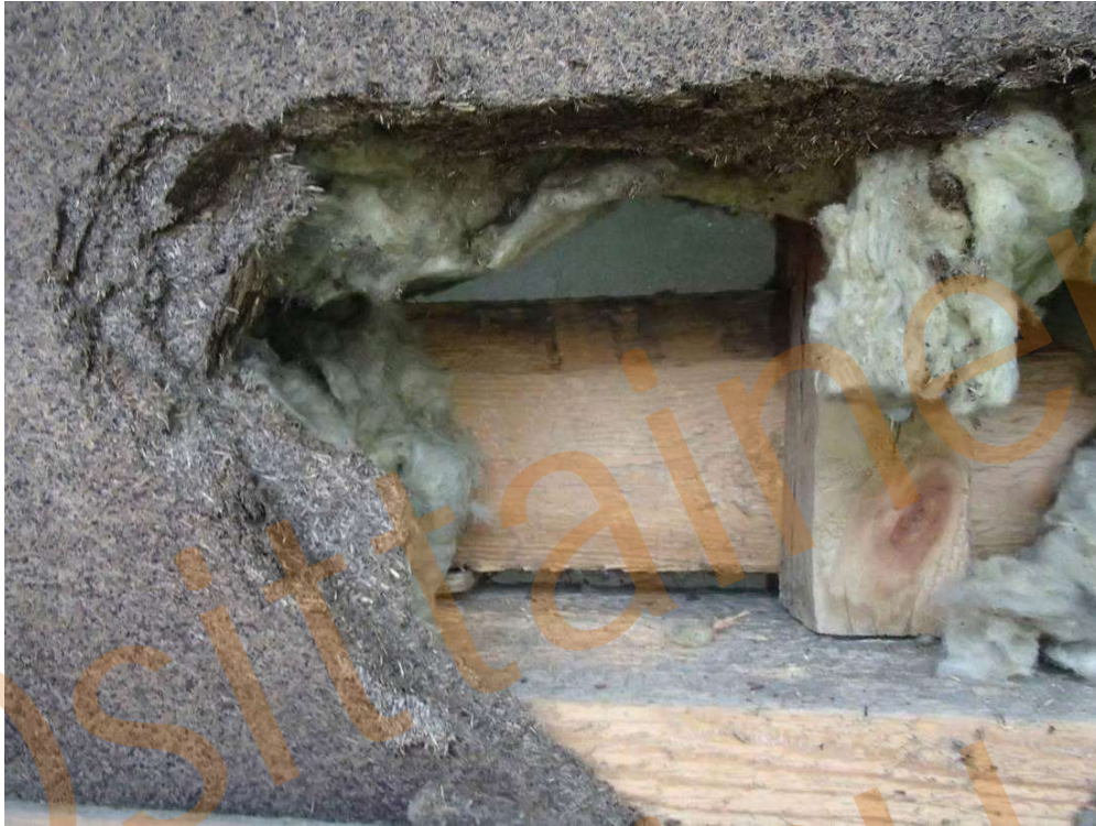
Kuva 89. Rakenneavaus, RAKS 24, opettajienhuoneen ikkunoiden yläpuolelle.
