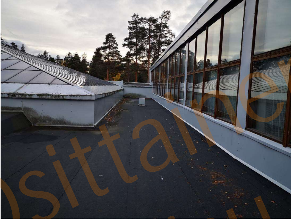
Kuva 151. Juhlasalin ja pyramidin ylösnostojen pellitykset.
