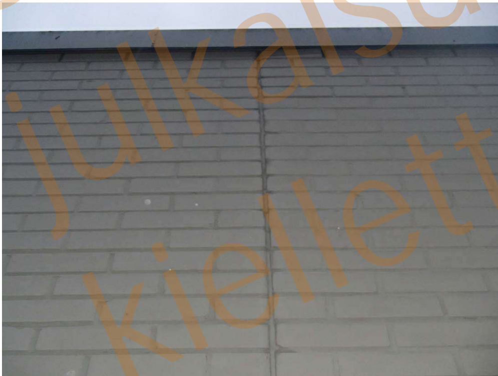
Kuva 146. Elastiset saumamassat ovat ikääntyneet.
