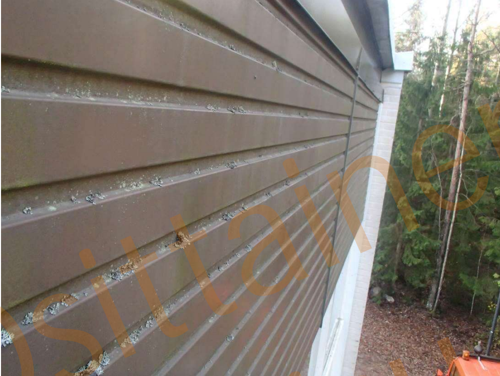
Kuva 122. Profiilipellityksen päällä kasvaa sammalta ja jäkälää.
