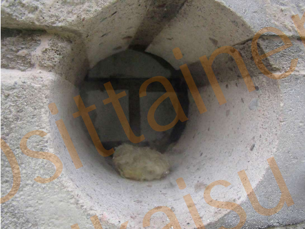
Kuva 105. Rakenneavaus, RAKS 32, auditorion kastuneeseen ulkovaipparakenteeseen.
