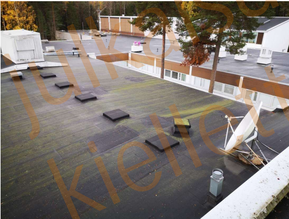
Kuva 159. Kattopinnoilla on leväkasvillisuutta.
