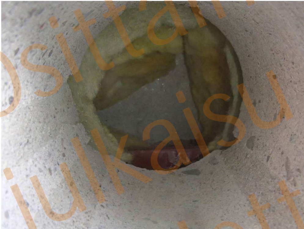
Kuva 79. Rakenneavaus, RAKS 19, metallityöluokan ikkunan yläpuolelle.
