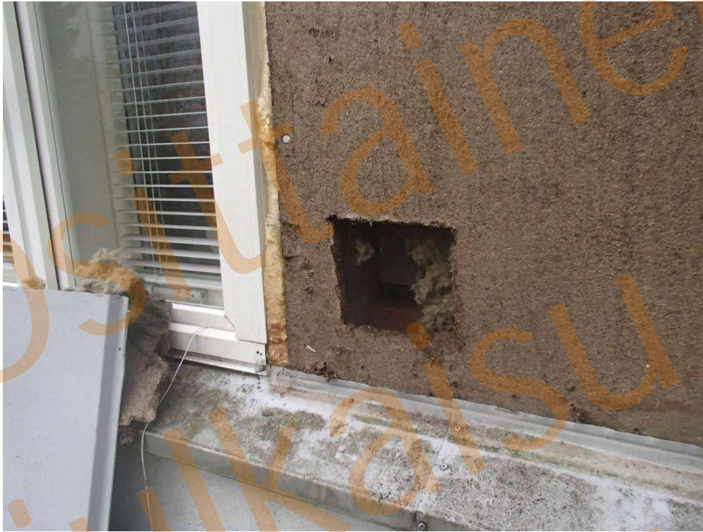
Kuva 94. Rakenneavaus, RAKS 26, opettajienhuoneen ikkunoiden väliin.
