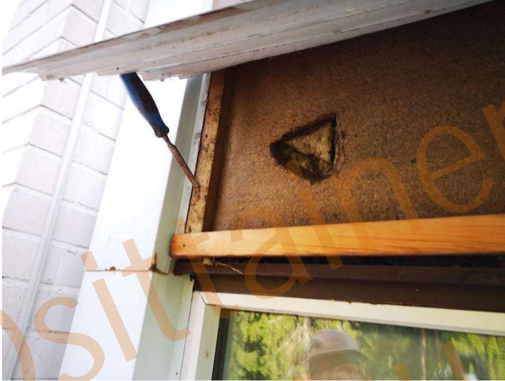
Kuva 86. Rakenneavaus, RAKS 23, liikuntasalin ikkunoiden yläosaan.
