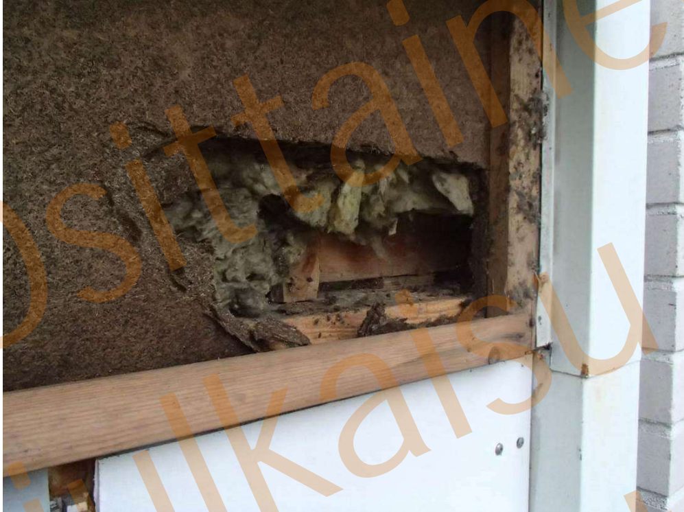
Kuva 88. Rakenneavaus, RAKS 24, opettajienhuoneen ikkunoiden yläpuolelle.
