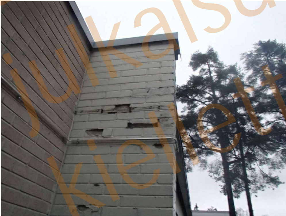
Kuva 23. Tiilimuurauksen vaurioita.
