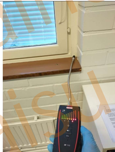
Kuva 46. Merkkiaineen ilmaisimella ilmoitetaan vuodon ikkunaliittymässä
