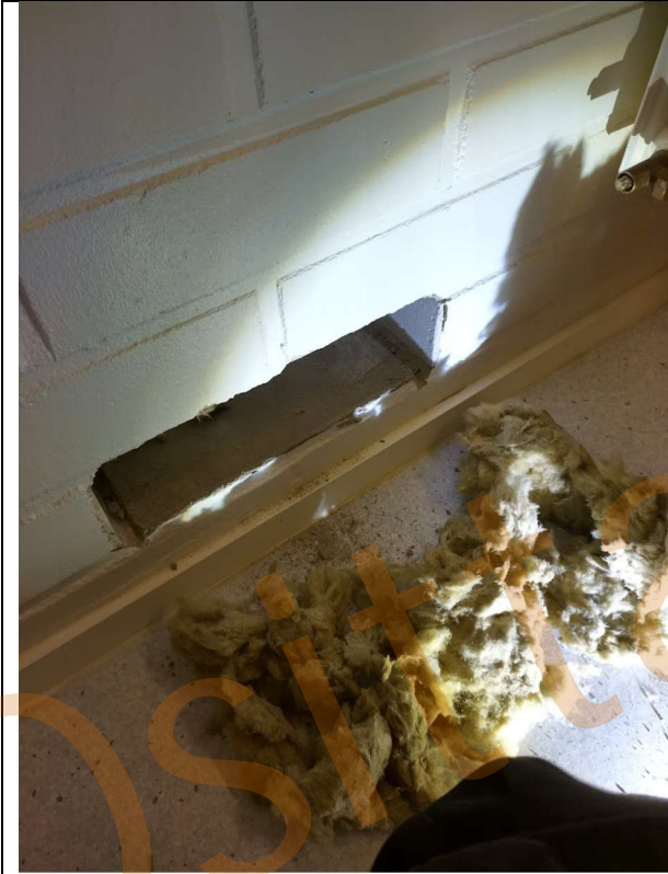
Kuva 41. Rakenneavaus ulkoseinään, h. 214
