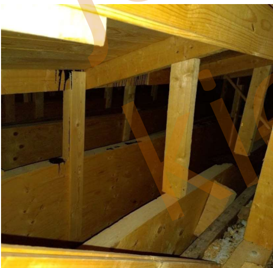
Kuva 12. Yläpohjan tuuletustila, 1967 rakennettu osio.
